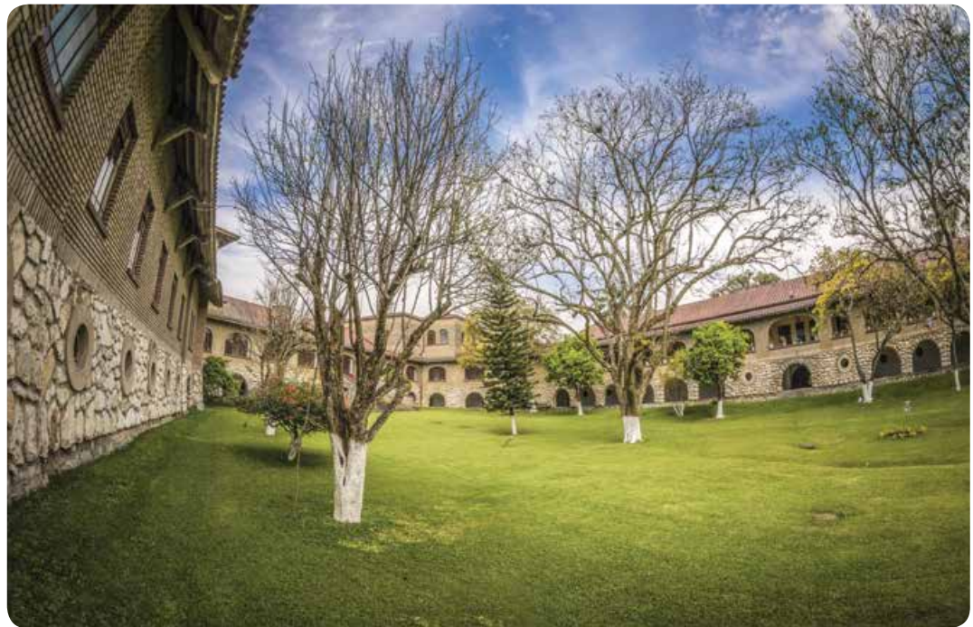
Edificio Mier y Pesado. The Mier y Pesado building.
